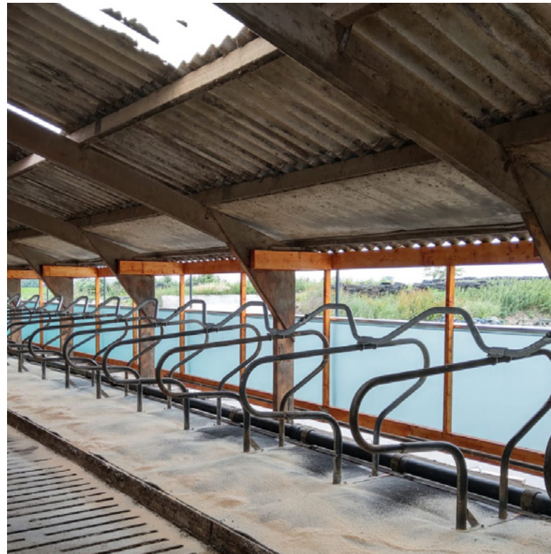
Ligplaats na renovatie
