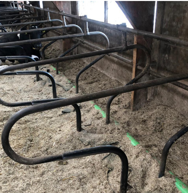
Ligplaats voor renovatie
