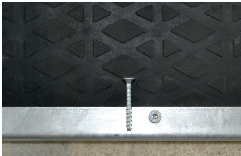
• Montage thermisch verzinkt bevestigingsprofiel d.m.v. betonschroeven
